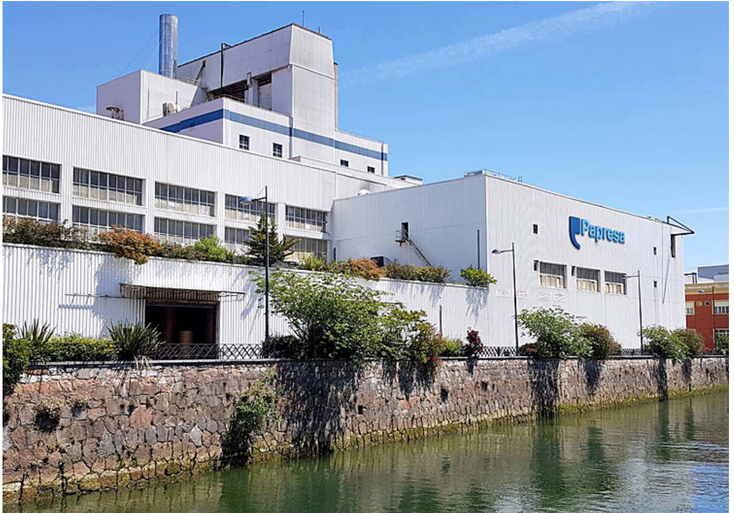
Exterior de la fábrica Papresa, en Errenteria.
