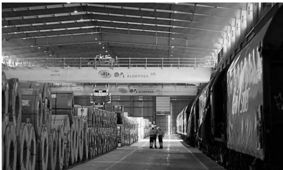
Interior del pabellón ampliado de Algeposa en el Puerto de Pasaia.
