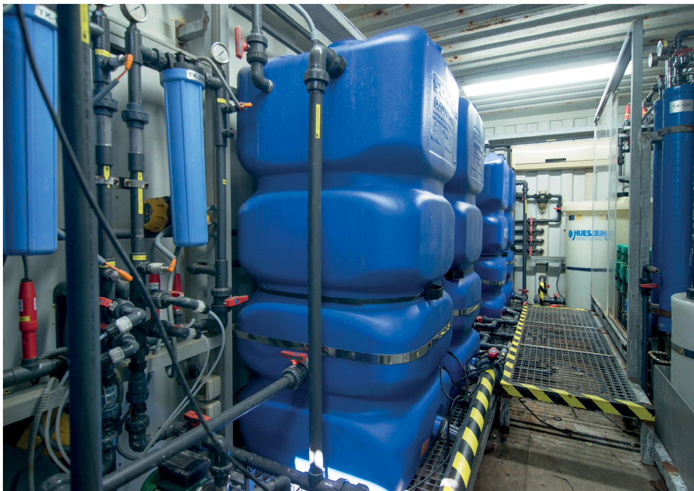
Figura 2. Detalle del interior (izquierda) y exterior (derecha) de la instalación para el testeo de membranas de ósmosis inversa.
